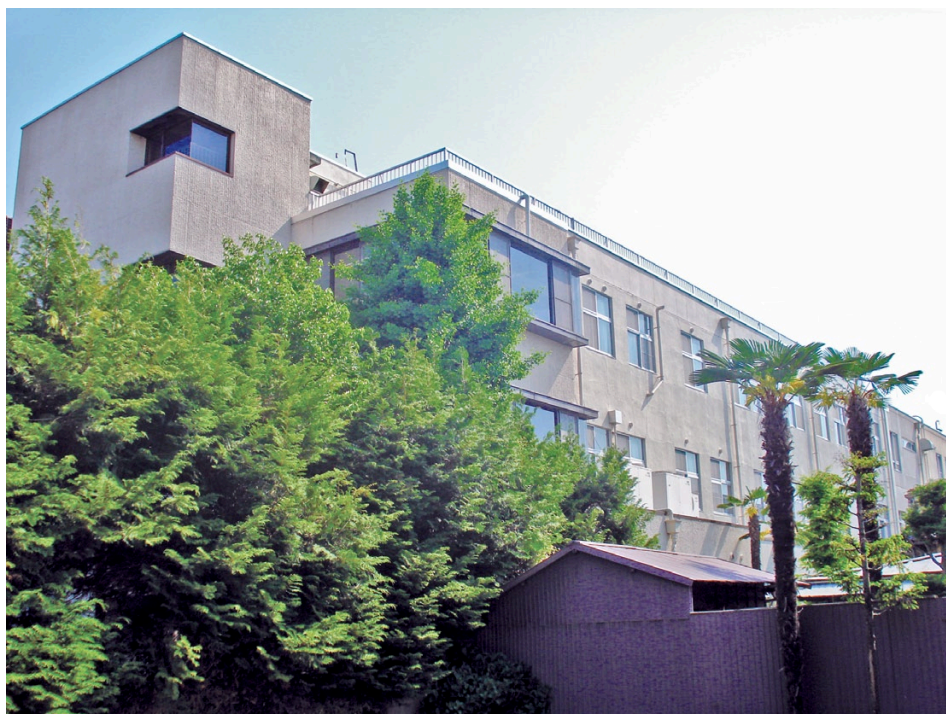
沼尾病院東側より
