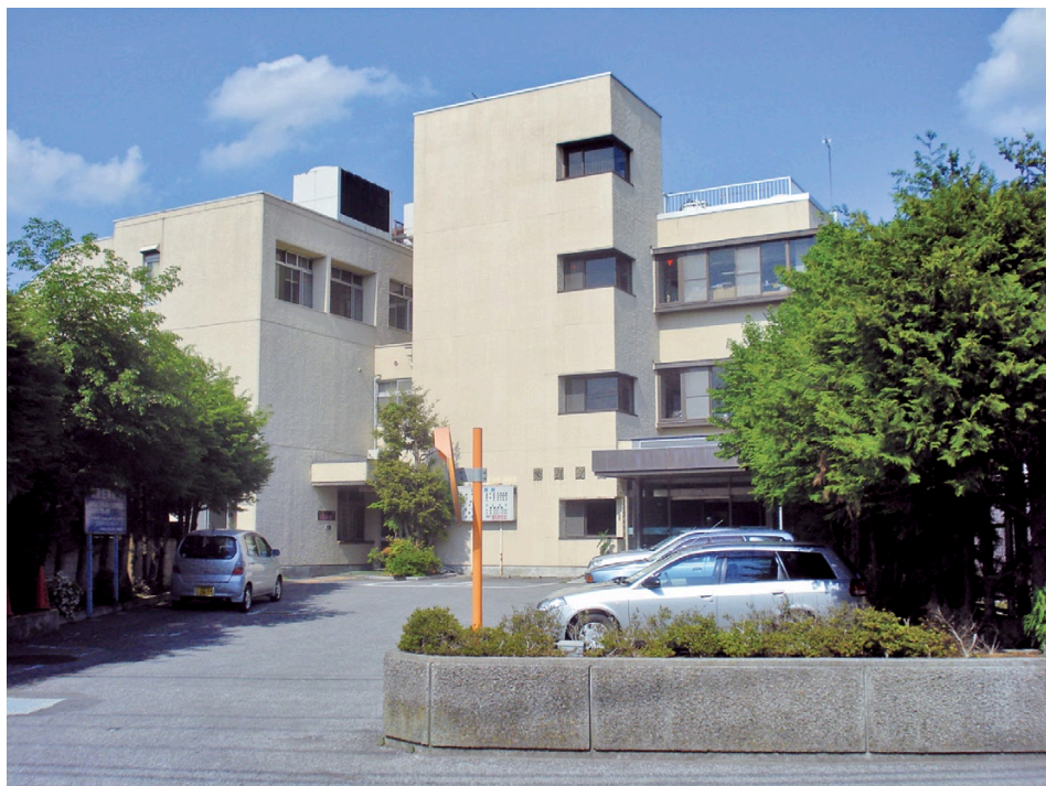
沼尾病院南側より正面玄関を望む
